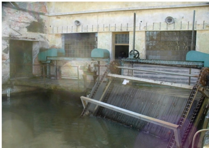
Obr.: Nátokový objekt do MVE Rajhrad a původní strojní zařízení – stav v únoru 2016
